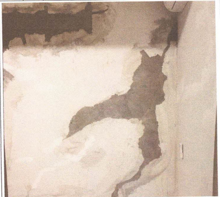
Descrição: REPARO DAS TRINCAS COM GRAMPOS E TELAS
