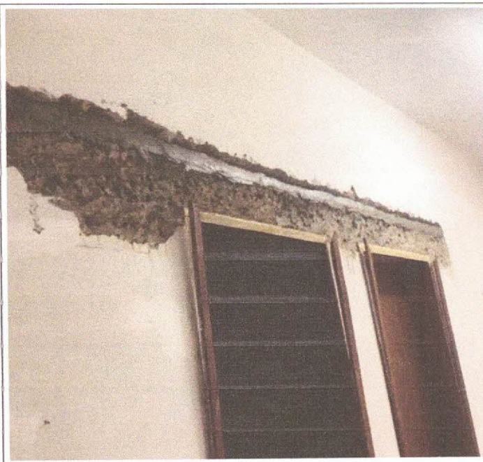
Descrição: CONCRETAGEM DAS VERGAS
