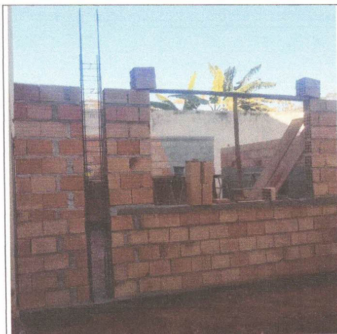
Descrição: ALVENARIA DE VEDAÇÃO E CONTRA-VERGA
