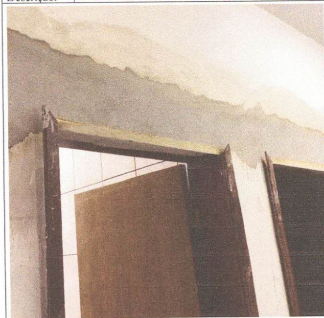
Descrição: ACABAMENTO EM REBOCO DAS VERGAS
