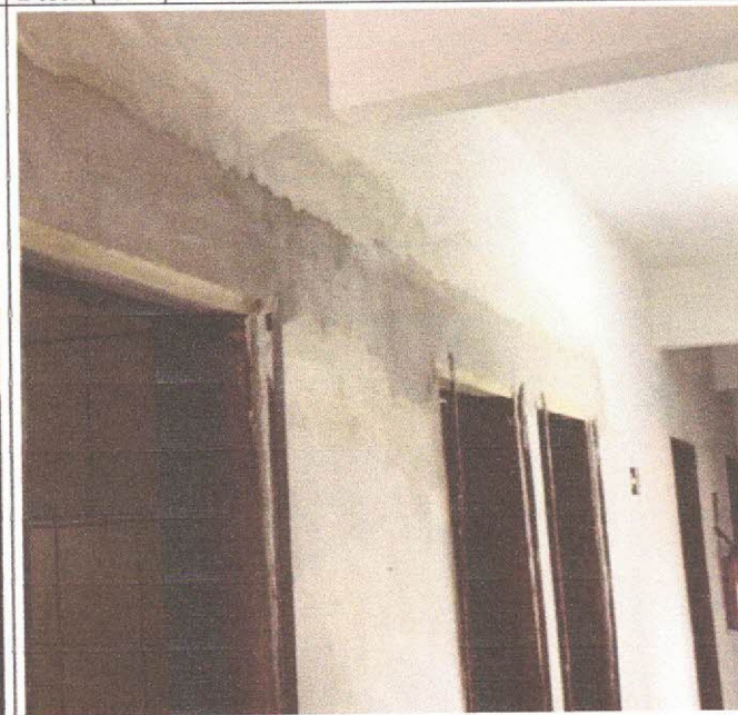
Descrição: ACABAMENTO EM REBOCO DAS VERGAS
