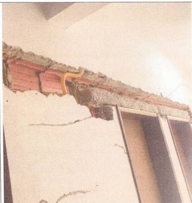
Descrição: PREPARATIVOS PARA REPAROS DAS VERGAS
