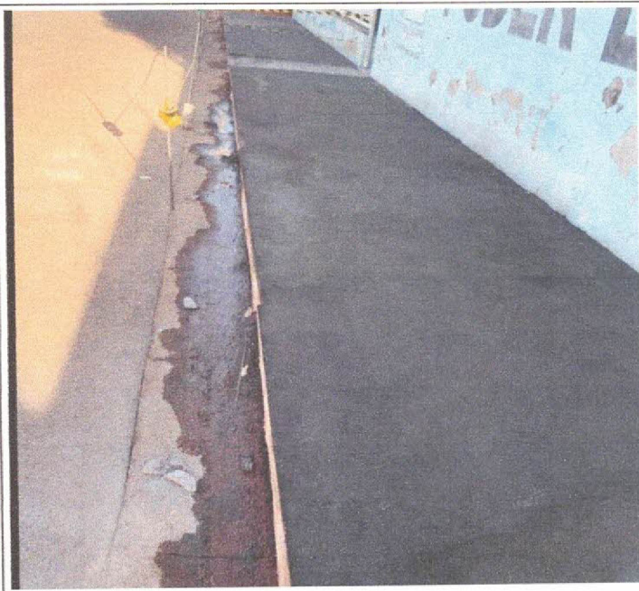
Descrição: CAMADA DE REGULARIZAÇÃO COM ARGAMASSA
