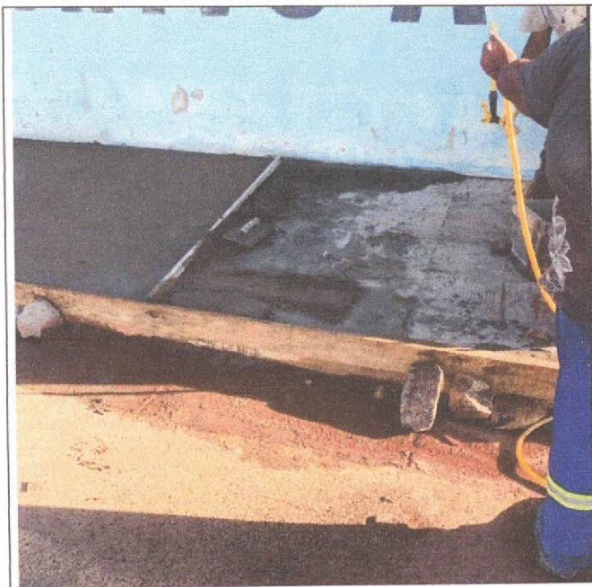
Descrição: CAMADA DE REGULARIZAÇÃO COM ARGAMASSA
