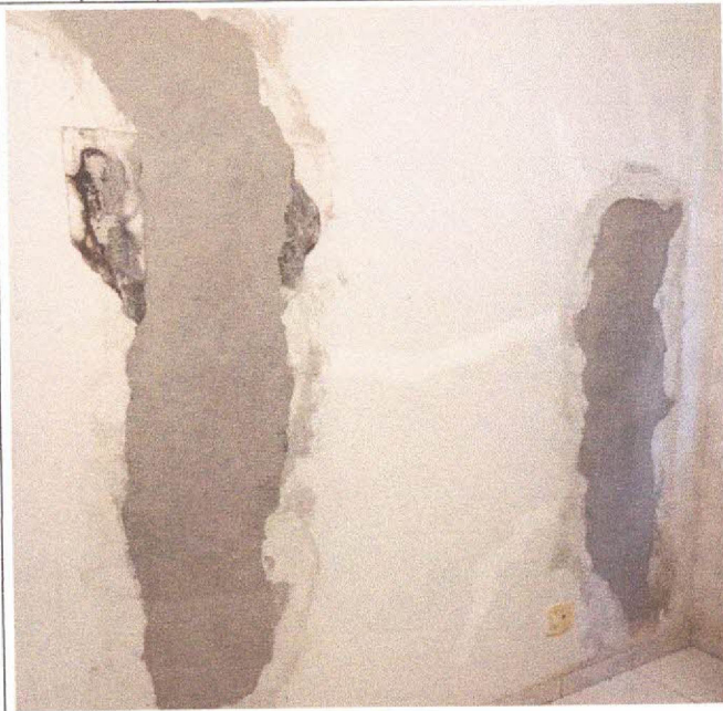
Descrição: REPARO DAS TRINCAS COM GRAMPOS E TELAS
