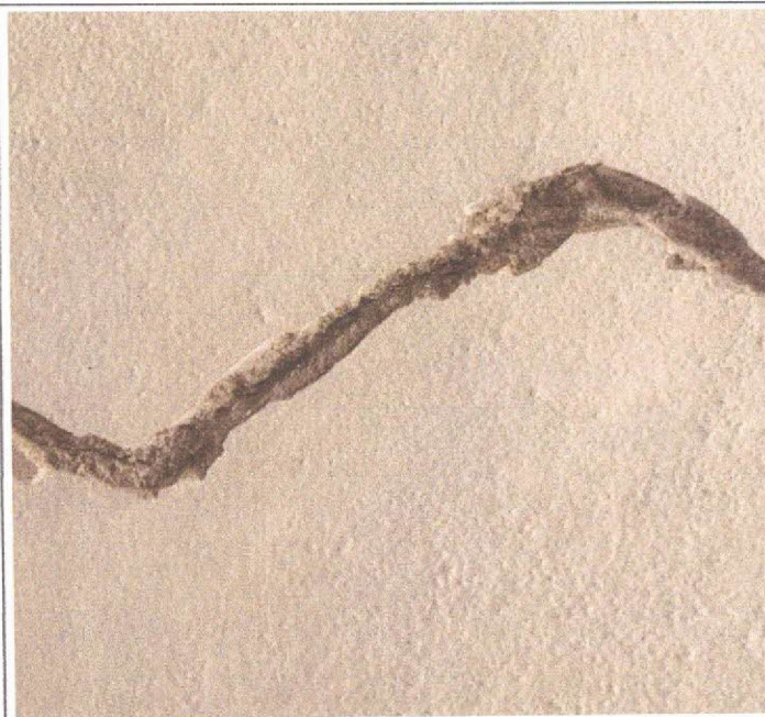
Descrição: PREPARATIVO PARA SELAMENTO DAS TRINCAS
