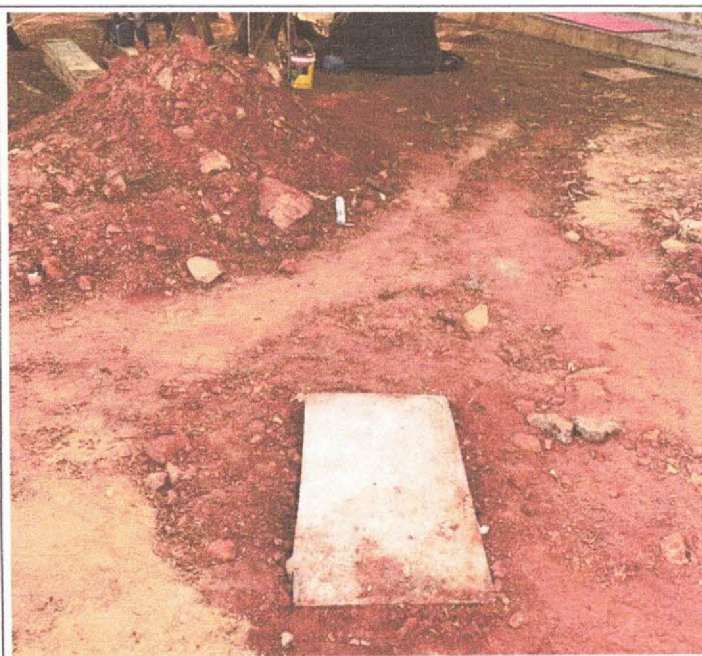
Descrição: RECOMPOSIÇÃO MANUAL DE VALAS
