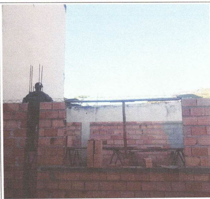
Descrição: ALVENARIA DE VEDAÇÃO E VERGA
