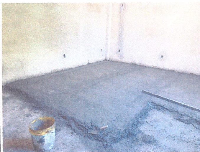
Descrição: IMAGEM 34: CIMENTAÇÃO COM POLIESTIRENO EXPANDIDO
