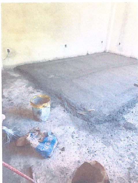
Descrição: CAMADA DE REGUALIZAÇÃO E ENCHIMENTO
