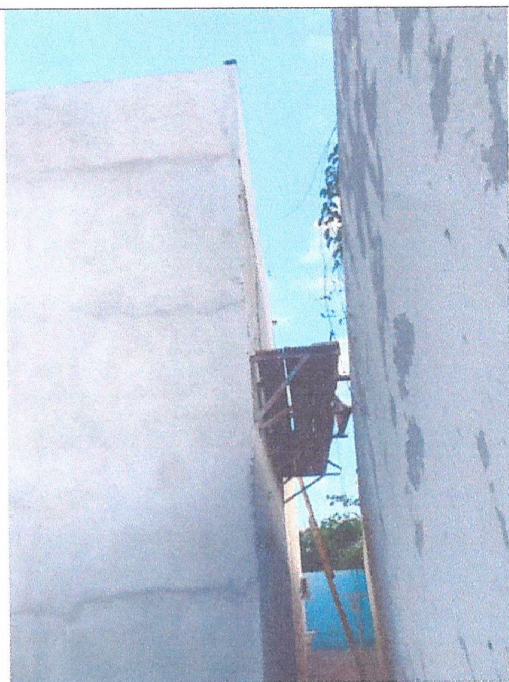
Descrição: IMAGEM 33: REBOCO EXTERNO DA AMPLIAÇÃO DO PREDIO SEDE
