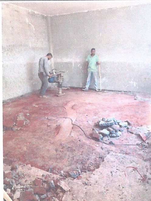
Descrição: IMAGEM 36: COMPACTAÇÃO DO SOLO DO PAVIMENTO TERREO
