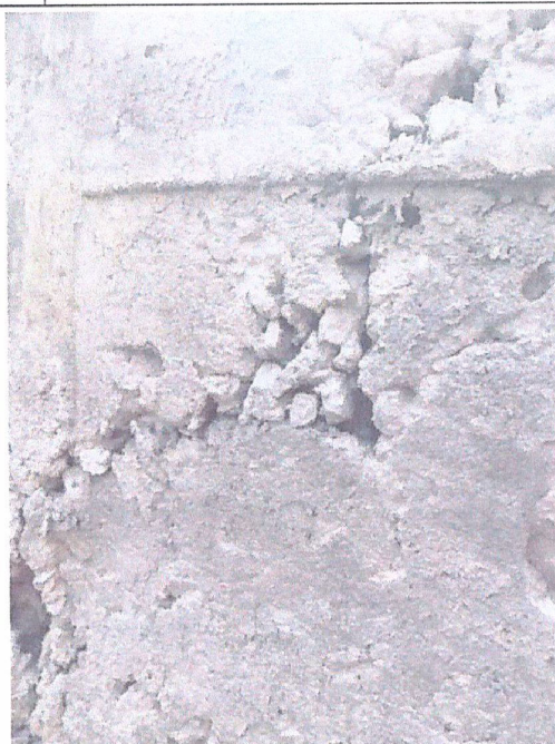
Descrição: IMAGEM 32: TRINCA APRESENTADA PELA MÁ EXECUÇÃO DA VIGA
