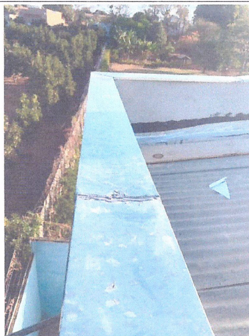
Descrição: IMAGEM 10: INSTALAÇÃO DE PINGADEIRAS E RUFOS.
