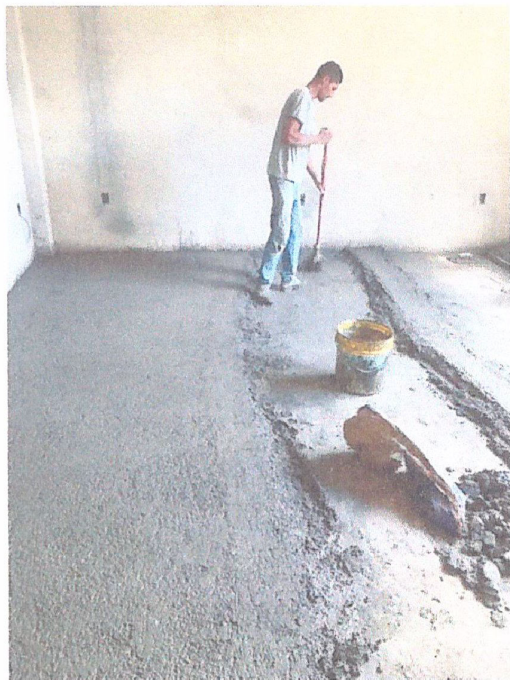
Descrição: CAMADA DE REGUALIZAÇÃO E ENCHIMENTO
