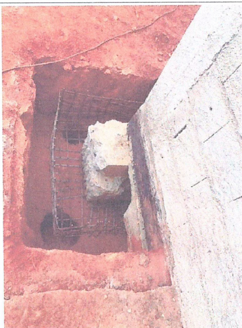
Descrição: IMAGEM 30: ACORAGEM DA FERRAGEM PARA CRIAÇÃO DAS SAPATAS ISOLADAS
