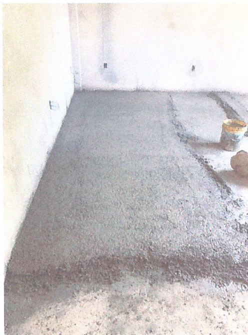
Descrição: CAMADA DE REGUALIZAÇÃO E ENCHIMENTO
