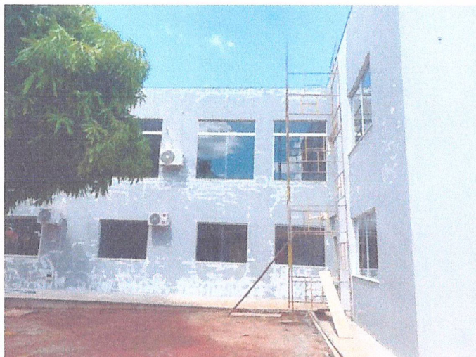
Descrição: TRATAMENTO DE TRINTCAS E FISSURAS DOS MUROS
