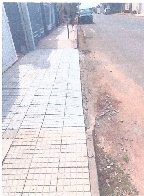
Descrição: ASSENTAMENTO DE PISO PODOTÁTIL
