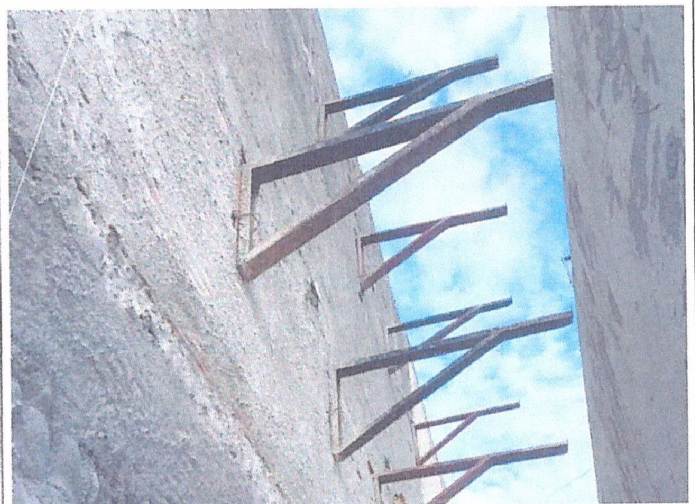
Descrição: CHAPISCO PLATIBANDAS E ELEVAÇÃO DO 2º PAV.
