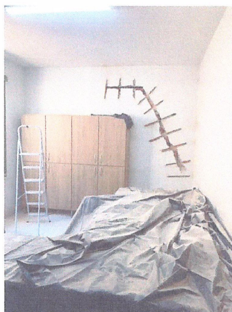
Descrição: COSTURA DAS TRINCAS
