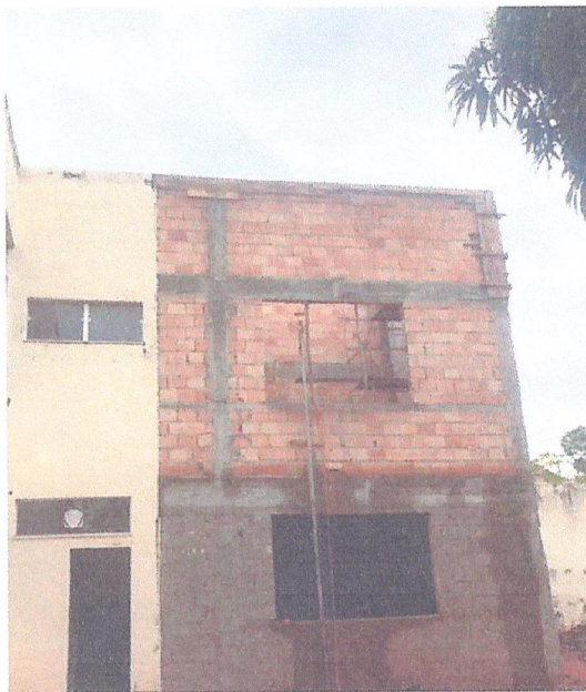
Descrição: SUPERESTRUTURA PLATIBANDAS
