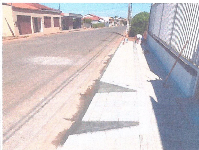
Descrição: ASSENTAMENTO DE PISO PODOTÁTIL
