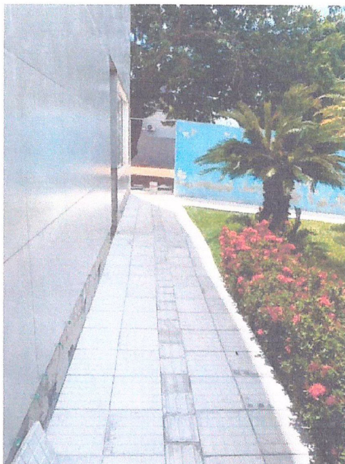
Descrição: ASSENTAMENTO DE PISO PODOTÁTIL
