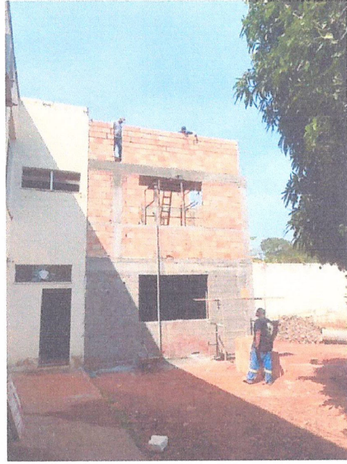
Descrição: ACRESCIMOS ALVENARIA DAS PLATIBANDAS
