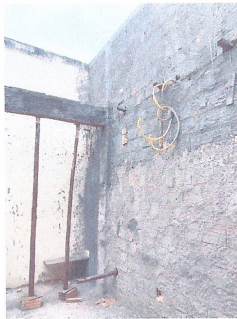
Descrição: CHAPISCO PLATIBANDAS E ELEVAÇÃO DO 2º PAV.
