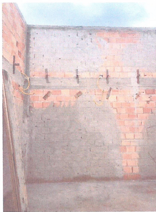
Descrição: SUPERESTRUTURAS PLATIBANDAS
