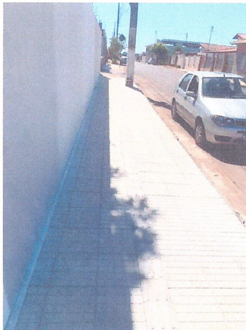
Descrição: ASSENTAMENTO DE PISO PODOTÁTIL
