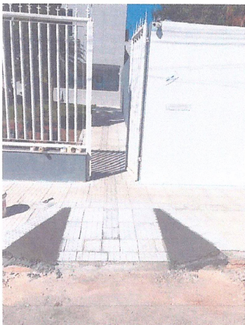
Descrição: ASSENTAMENTO DE PISO PODOTÁTIL
