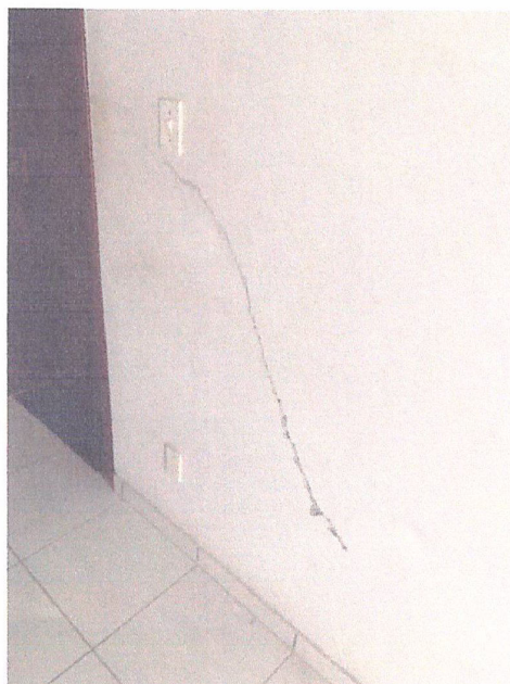
Descrição: TRATAMENTO DE FISSURAS
