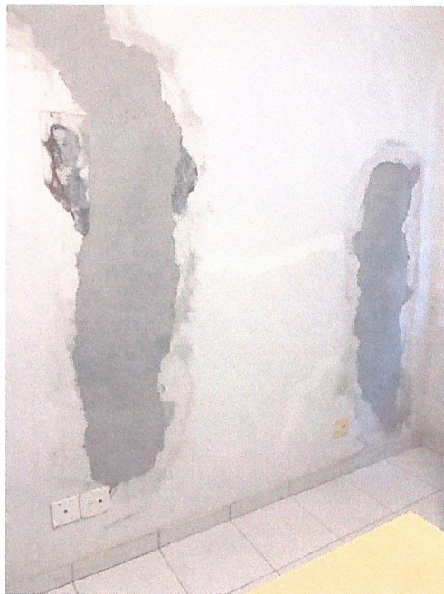
Descrição: COSTURA DAS TRINCAS E RECOMPOSIÇÃO DO REVESTIMENTO
