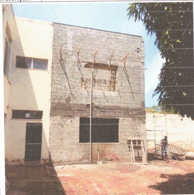
Descrição: CHAPISCO EXTERNO DA AMPLIAÇÃO
