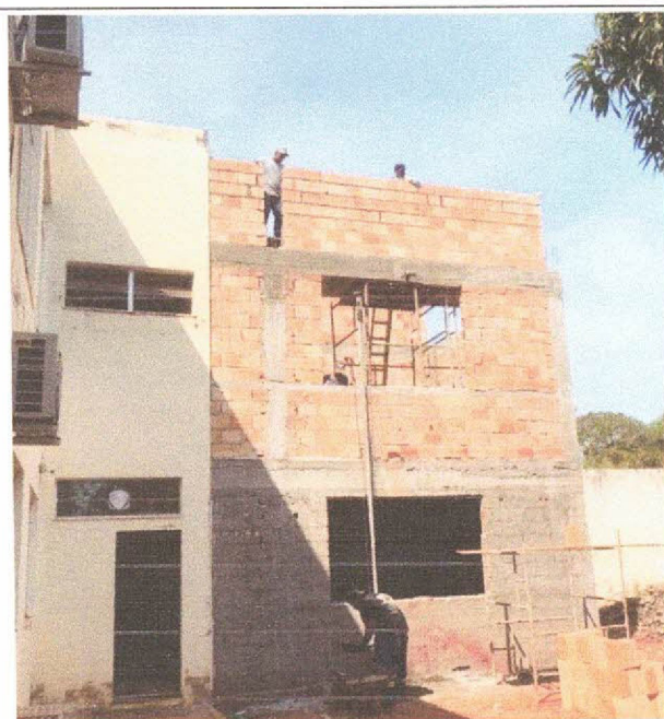
Descrição: EXECUÇÃO DE ALVENARIA DA SUPERESTRUTURA
