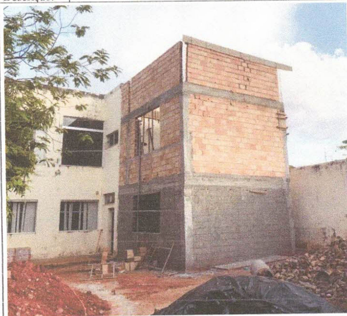
Descrição: EXECUÇÃO DE ALVENARIA DA SUPERESTRUTURA
