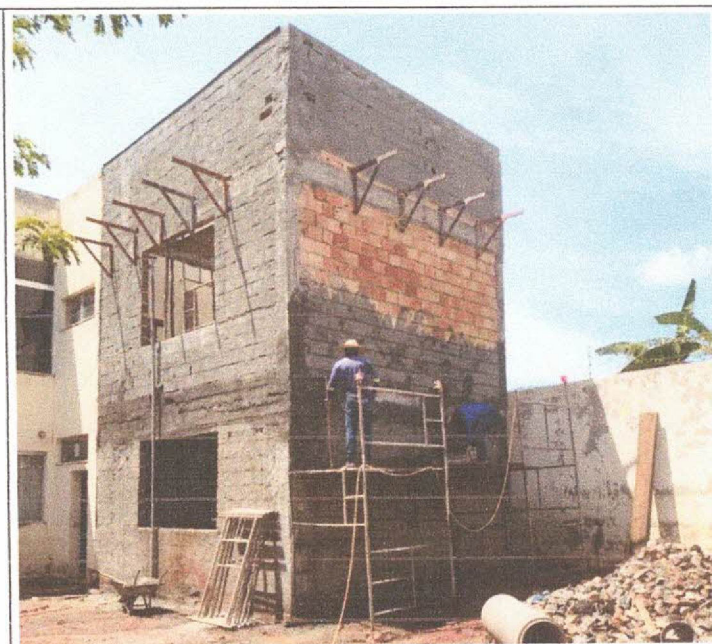
Descrição: CHAPISCO EXTERNO DA AMPLIAÇÃO
