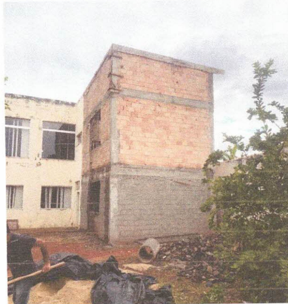
Descrição: RESPALDO DA SUPERESTRUTRA
