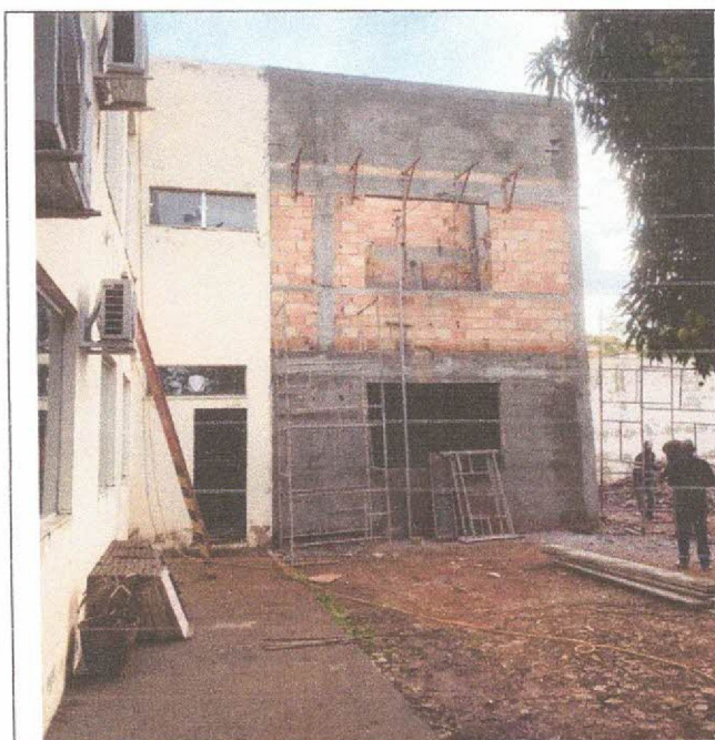
Descrição: CHAPISCO EXTERNO DA AMPLIAÇÃO
