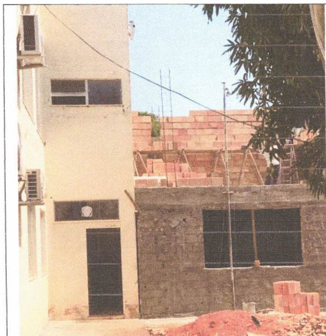
Descrição: EXECUÇÃO DE ALVENARIA DE VEDAÇÃO DO 2º PAV.
