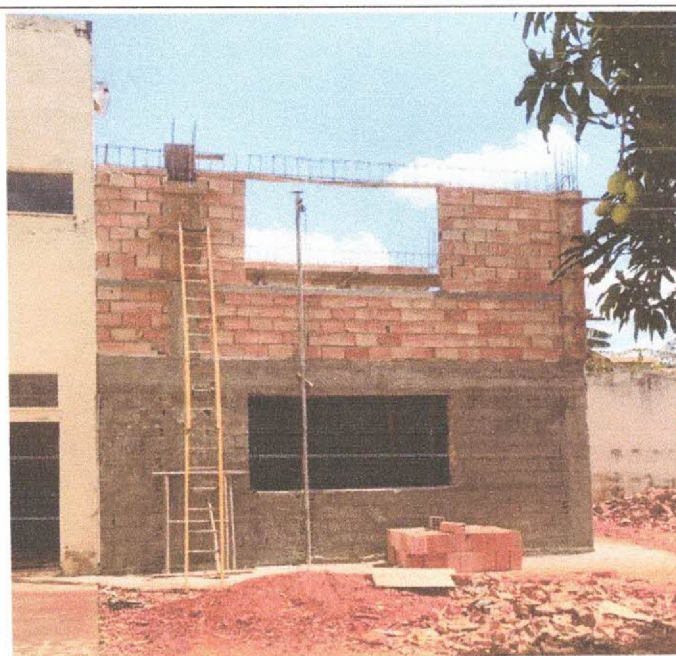
Descrição: EXECUÇÃO DE ALVENARIA DE VEDAÇÃO DO 2º PAV.
