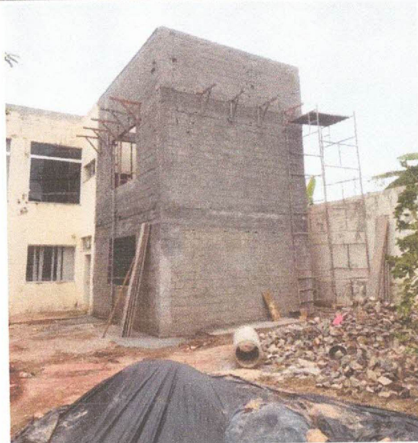
Descrição: CHAPISCO EXTERNO DA AMPLIAÇÃO
