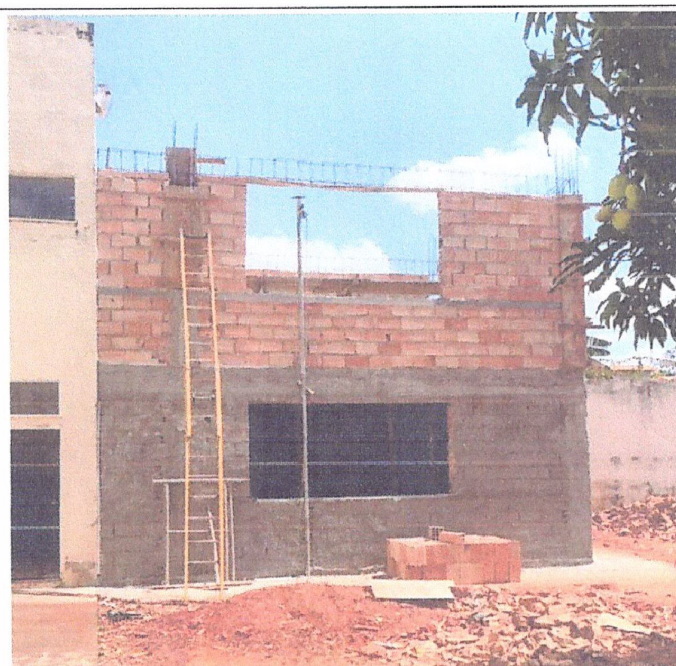
Descrição: EXECUÇÃO DE ALVENARIA DE VEDAÇÃO DO 2º PAV.
