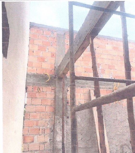
Descrição: CONCRETAGEM DE VIGA
