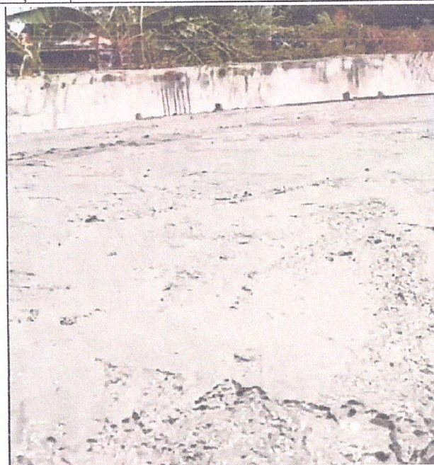
Descrição: CONCRETAGEM DA LAJE
