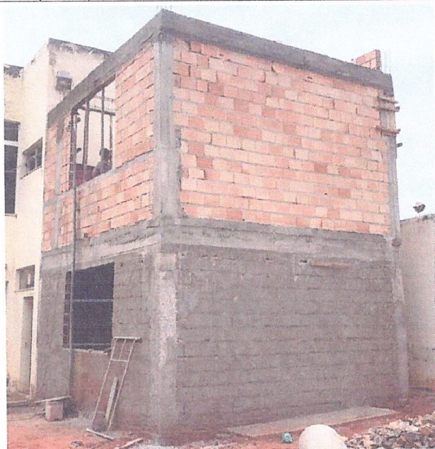
Descrição: EXECUÇÃO DE ALVENARIA E SUPERESTRUTURA
