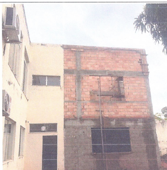
Descrição: RESPALDO DA SUPERESTRUTURA
