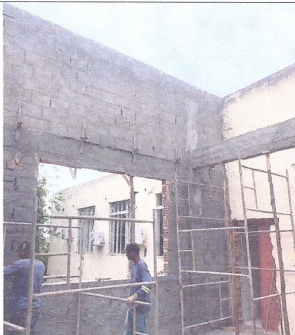
Descrição: CHAPISCO INTERNO DA AMPLIAÇÃO
