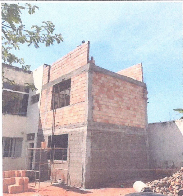
Descrição: EXECUÇÃO DE ALVENARIA DA SUPERESTRUTURA
