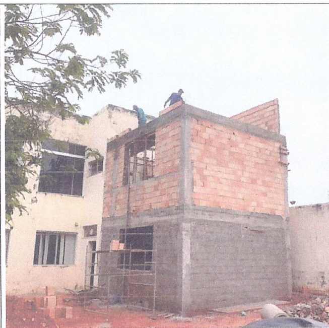
Descrição: EXECUÇÃO DE ALVENARIA DA SUPERESTRUTURA
