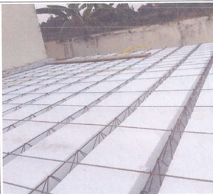
Descrição: MONTAGEM DA LAJE PRÉ-MOLDADA
