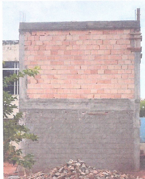
Descrição: EXECUÇÃO DE ALVENARIA E SUPERESTRUTURA
