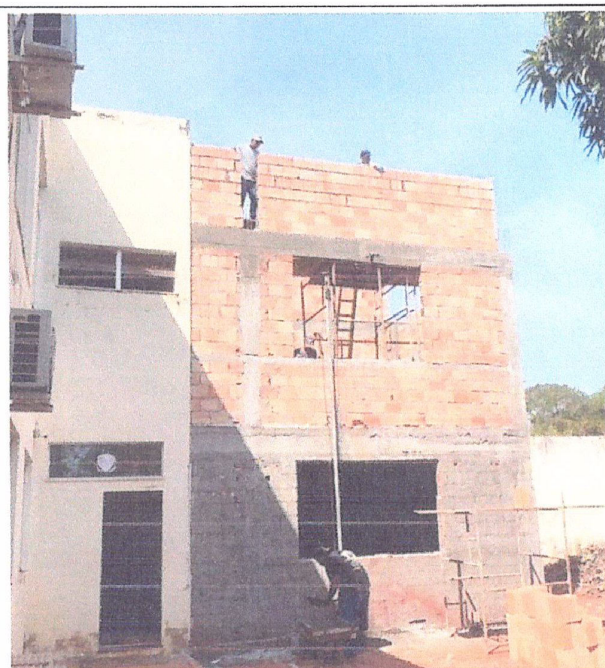
Descrição: EXECUÇÃO DE ALVENARIA DA SUPERESTRUTURA
