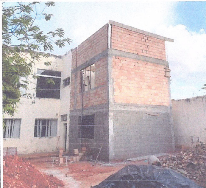
Descrição: EXECUÇÃO DE ALVENARIA DA SUPERESTRUTURA
