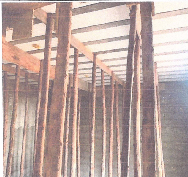
Descrição: MONTAGEM DA LAJE PRÉ-MOLDADA
