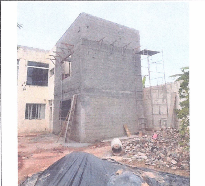
Descrição: CHAPISCO EXTERNO DA AMPLIAÇÃO
