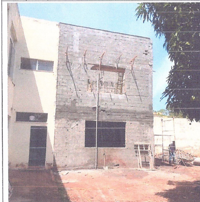
Descrição: CHAPISCO EXTERNO DA AMPLIAÇÃO
