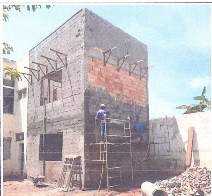
Descrição: CHAPISCO EXTERNO DA AMPLIAÇÃO
