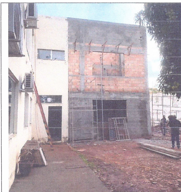
Descrição: CHAPISCO EXTERNO DA AMPLIAÇÃO
