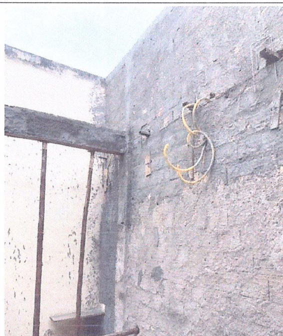
Descrição: CHAPISCO INTERNO DA AMPLIAÇÃO
