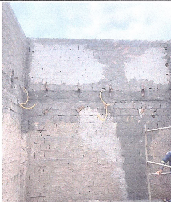
Descrição: CHAPISCO INTERNO DA AMPLIAÇÃO
