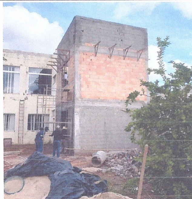
Descrição: CHAPISCO EXTERNO DA AMPLIAÇÃO
