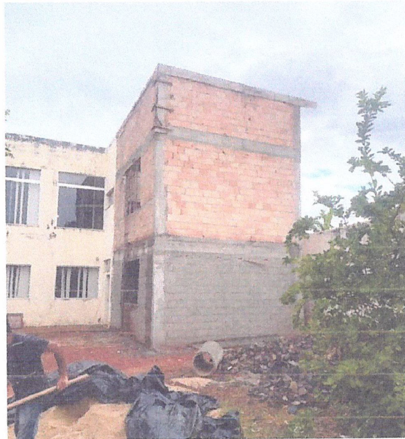
Descrição: RESPALDO DA SUPERESTRUTURA
