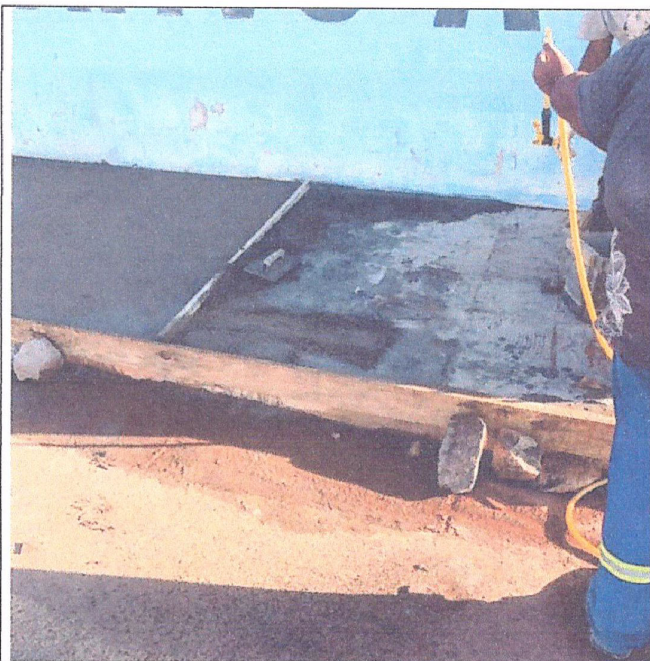
Descrição: CAMADA DE REGULARIZAÇÃO COM ARGAMASSA
