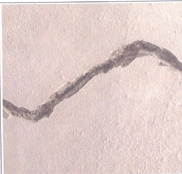
Descrição: PREPARATIVO PARA SELAMENTO DAS TRINCAS
