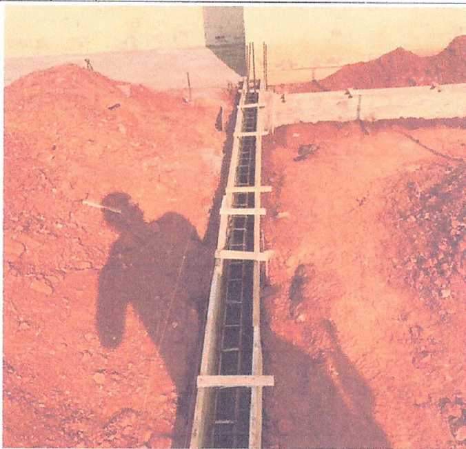
Descrição: MONTAGEM DE FORMAS PARA VIGAS BALDRAMES
