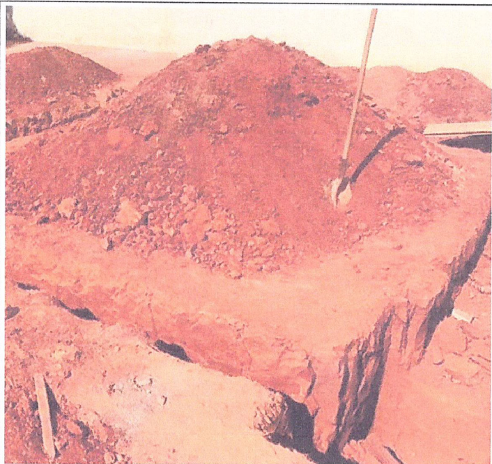
Descrição: ESCAVAÇÃO MANUAL DE VALAS
