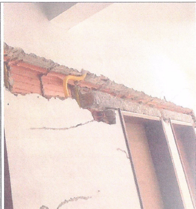
Descrição: PREPARATIVOS PARA REPAROS DAS VERGAS
