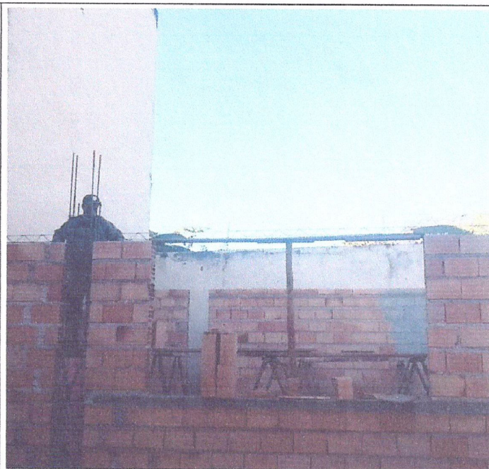
Descrição: ALVENARIA DE VEDAÇÃO E VERGA
