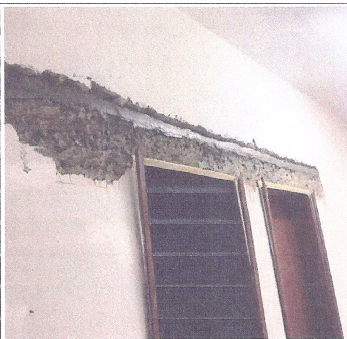
Descrição: CONCRETAGEM DAS VERGAS
