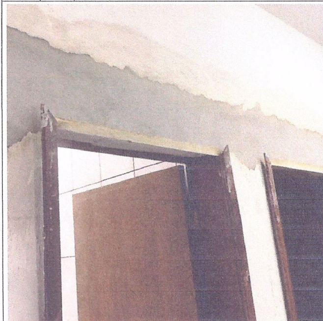
Descrição: ACABAMENTO EM REBOCO DAS VERGAS
