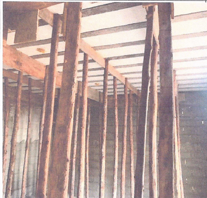
Descrição: ESCORAMENTO PARA LAJE PRÉ-MOLDADA
