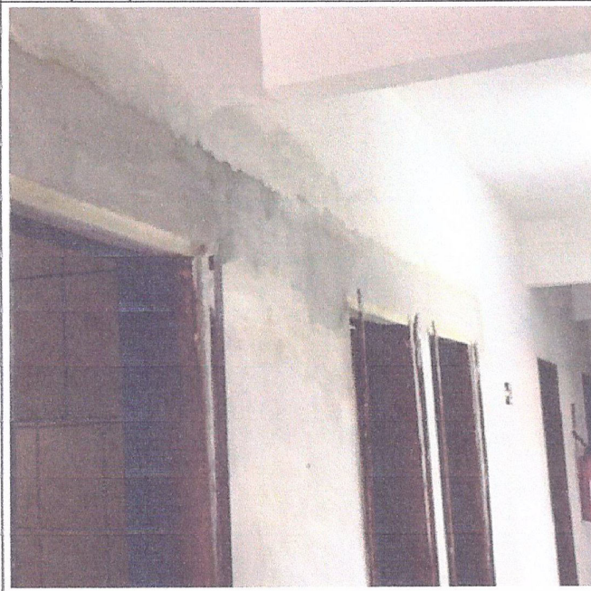
Descrição: ACABAMENTO EM REBOCO DAS VERGAS
