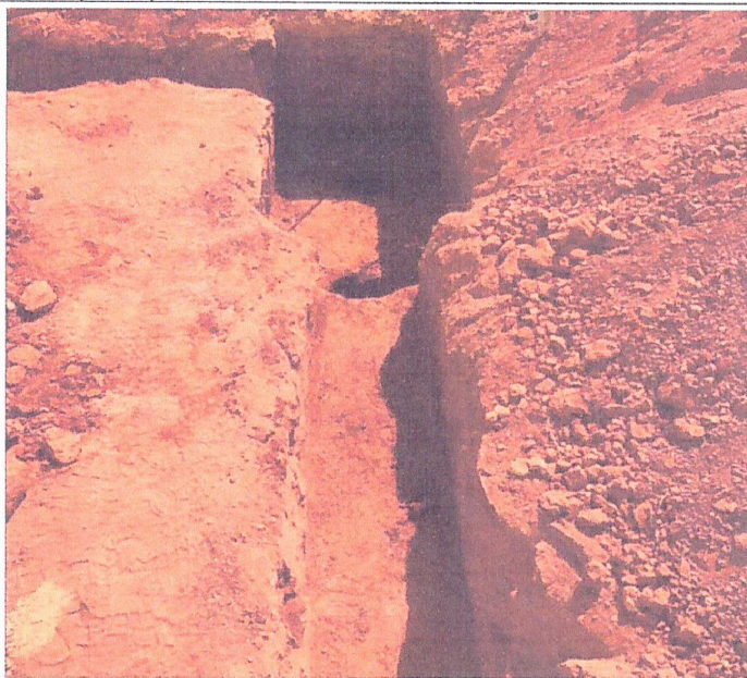
Descrição: ESCAVAÇÃO MANUAL DE VALAS
