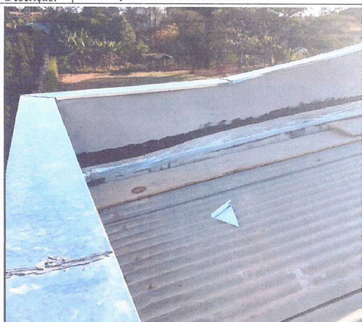
Descrição: INSTALAÇÃO DE RUFOS E MANTAS
