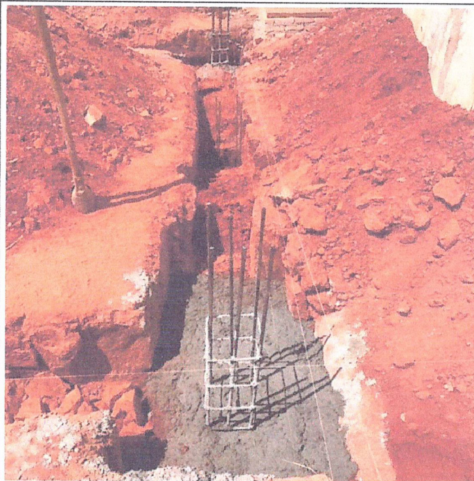
Descrição: ARMAÇÃO E CONCRETAGEM DOS BLOCOS
