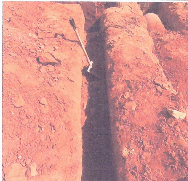
Descrição: ESCAVAÇÃO MANUAL DE VALAS
