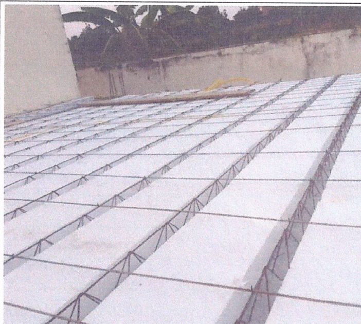
Descrição: MONTAGEM DA LAJE PRÉ-MOLDADA
