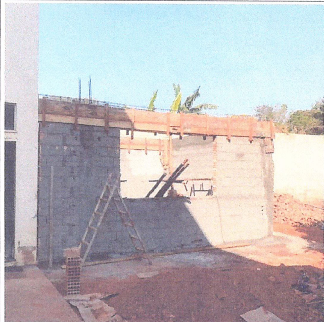
Descrição: ALVENARIA DE VEDAÇÃO E SUPERESTRUTURA
