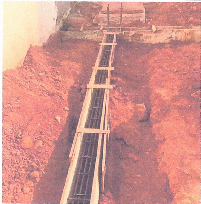
Descrição: MONTAGEM DE FORMAS PARA VIGAS BALDRAMES
