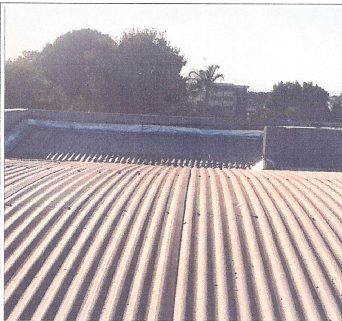
Descrição: INSTALAÇÃO DE RUFOS E MANTAS
