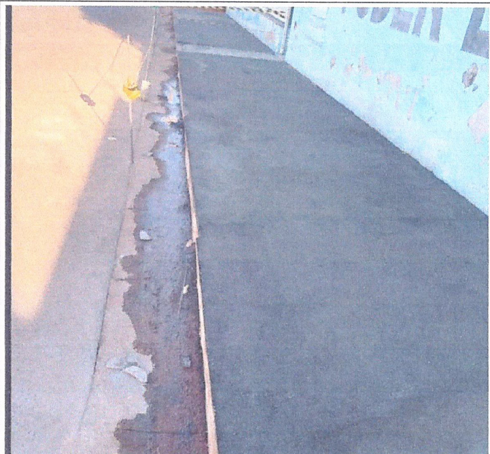
Descrição: CAMADA DE REGULARIZAÇÃO COM ARGAMASSA
