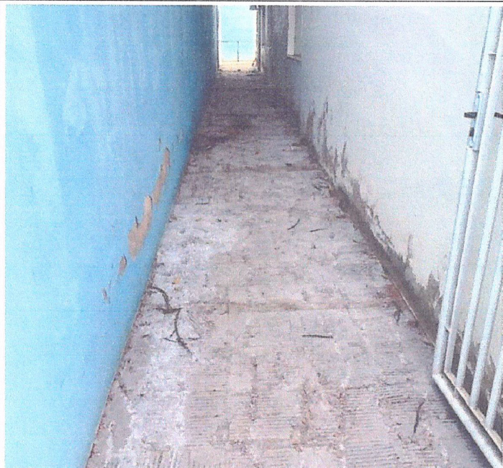
Descrição: DEMOLIÇÃO MANUAL DE PISO CERÂMICO
