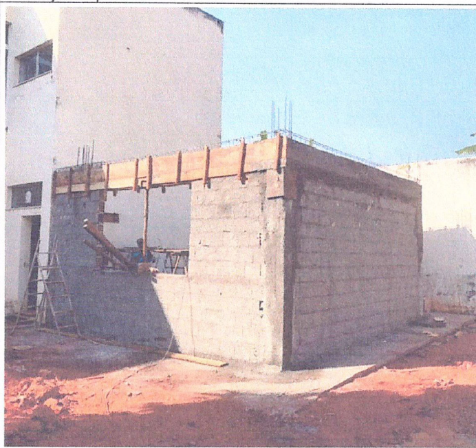
Descrição: ALVENARIA DE VEDAÇÃO E SUPERESTRUTURA
