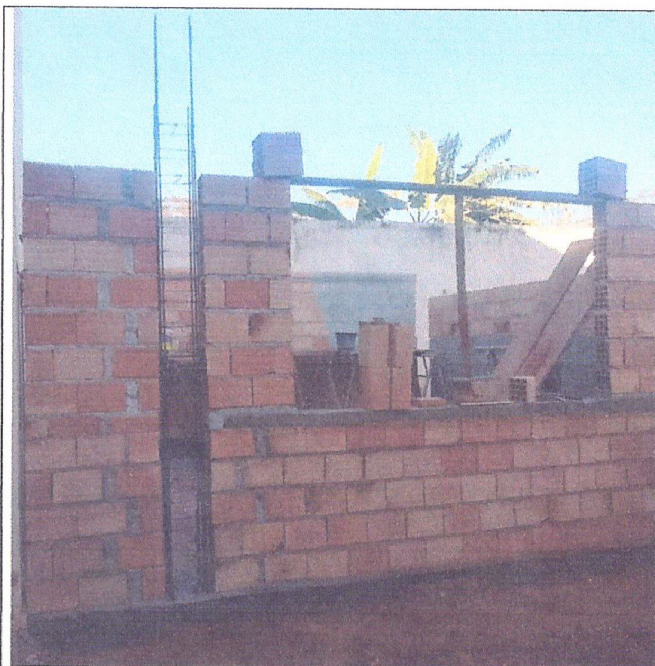
Descrição: ALVENARIA DE VEDAÇÃO E CONTRA-VERGA
